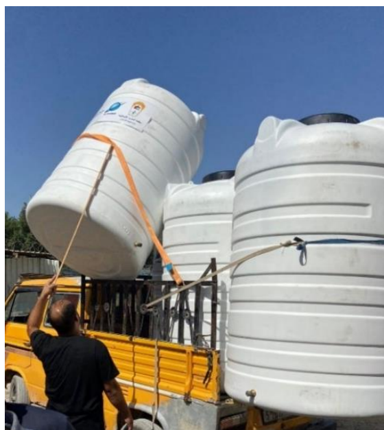
購入した貯水タンクをトラックから下ろしている。
