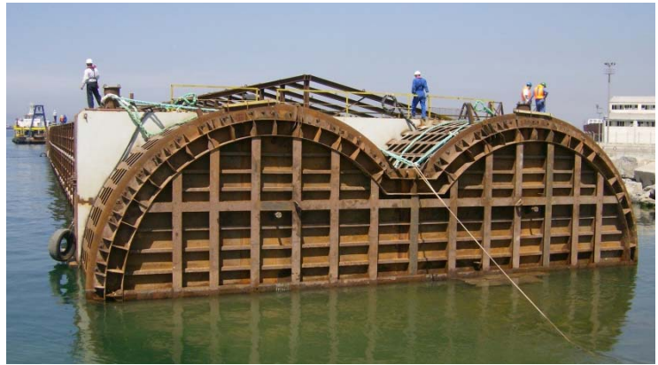
沈埋トンネル
